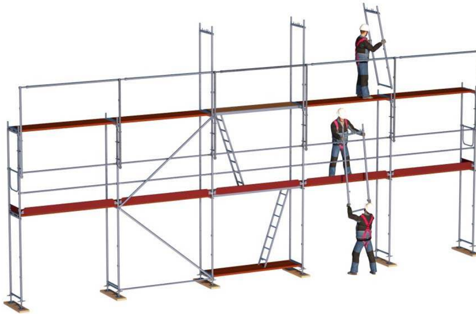
Bild 30: Montage der Gerüstlage im Schutze des MSG.
