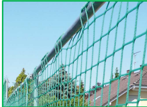
Beispiel für Maschenweite ca. 45 (50) mm und 60 mm: Das Netz ist in jeder 3. Masche auf das Gerüstrohr aufgefädelt
