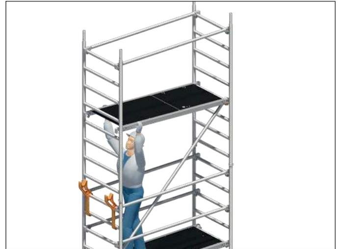
4. Diagonalen 21 und Durchstiegsbrücke 26 einsetzen. Die Diagonalen müssen auf beiden Seiten turmartig (Zick-zack-Form) eingebaut werden.
