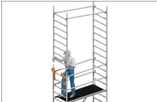
3. Standleiter 13 mit Geländern 18 nach oben schwenken, aufstecken und mit Federsteckern 17 sichern.
